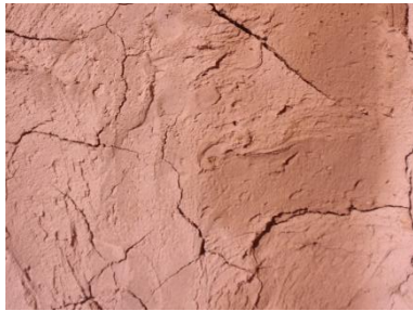
Tierra de obra con arena
