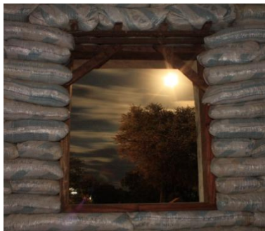
Muros durante su construcción
