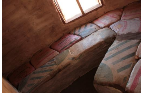
Construcción de las camas simples
