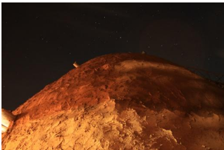
Vista de la primera capa de revoque
