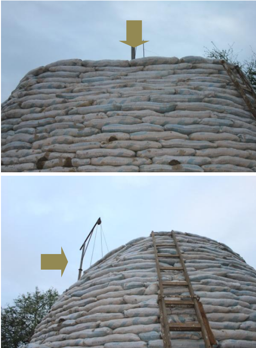
Vistas de la deformación entre la fila 38 a la 41
