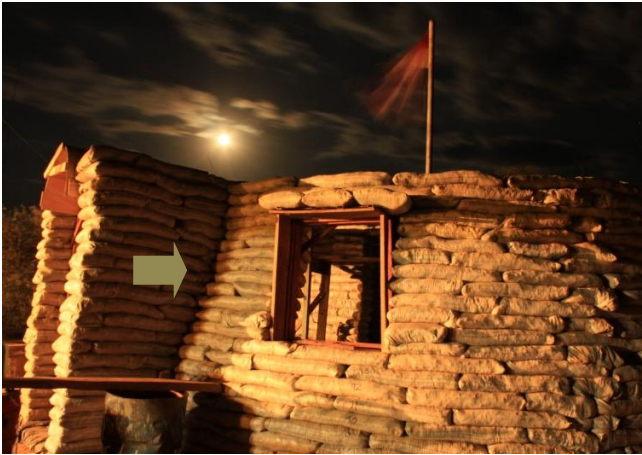
Deformación del muro
