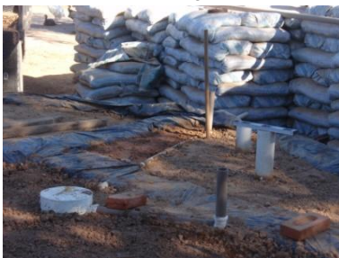
Instalación ya enterrada
