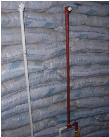
Instalación para ducha y cisterna
