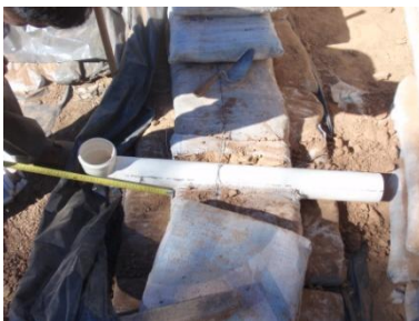
Instalación a través de las bolsas
