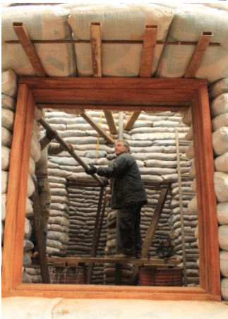
Estructura del dintel
