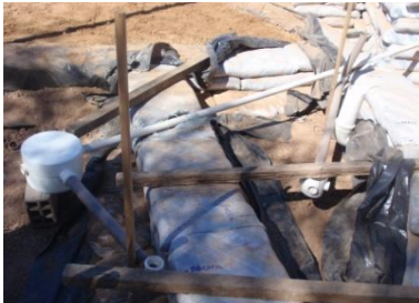
Instalación del desagüe cloacal
