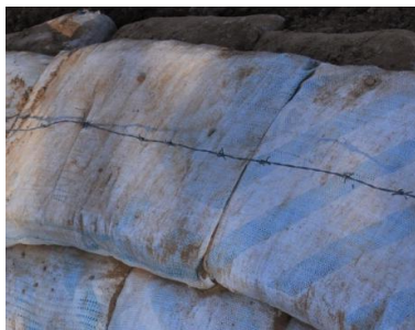
Colocación del alambre de púas
