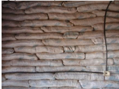
Conexión de una toma
