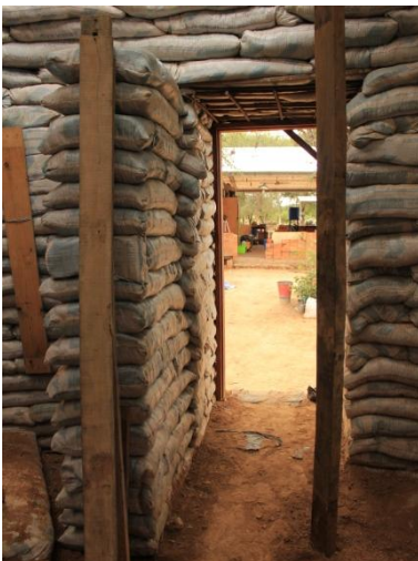
Construcción del contrafuerte
