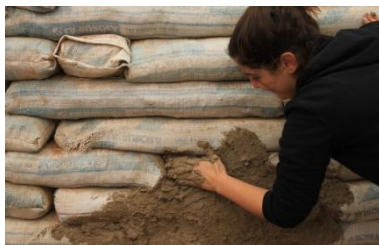
Colocando el revoque
