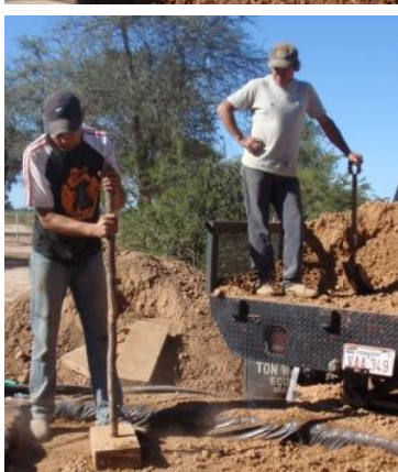
Proceso de nivelación
