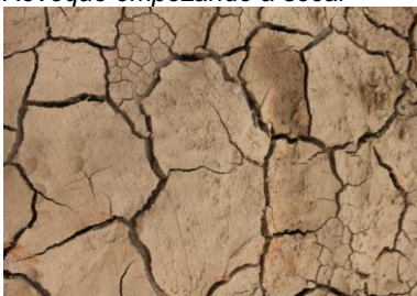
Revoque de arcilla negra seco
