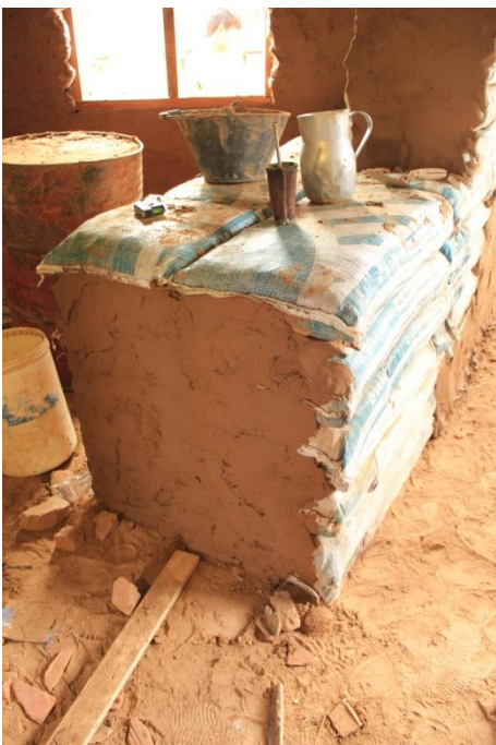
Colocación del revoque interior en grueso
