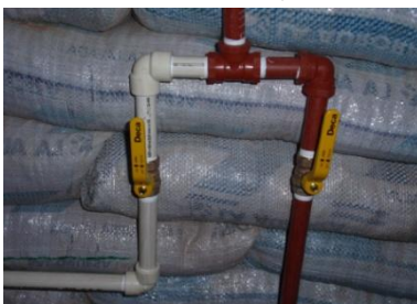
Mezclador y llaves de agua fría y caliente
