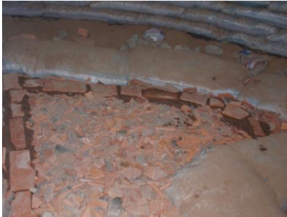
Colocación del contrapiso
