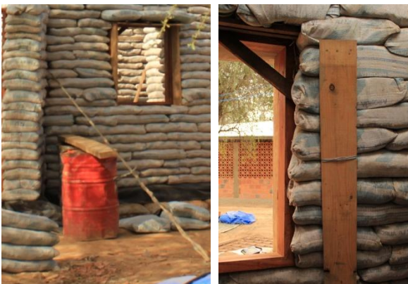
Vista exterior e interior del cabo tensor
