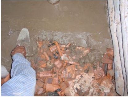
Colocación de la mezcla
