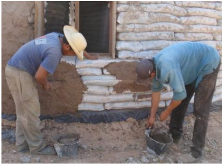
Colocación del revoque con cuchara
