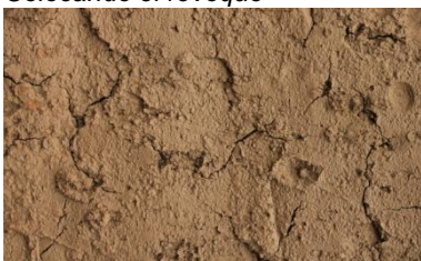
Revoque empezando a secar
